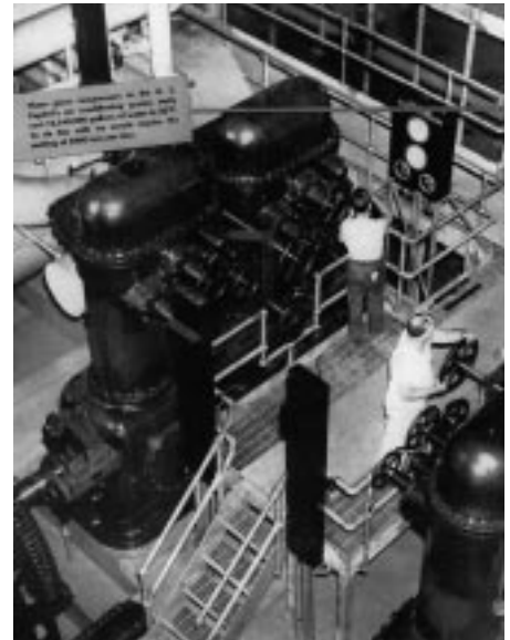
Um 1930: Das Gebäude des US Capitol in Washington wird klimatisiert. Ca. 3,2 Mio. Liter Wasser werden täglich auf etwa 4,5 °C abgekühlt
