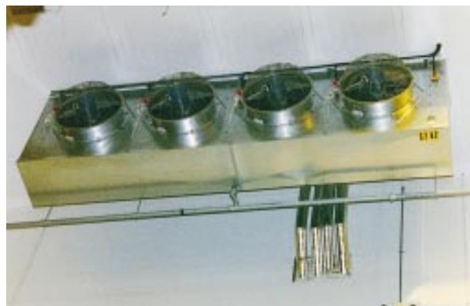
Küba's Ventilatorluftkühler für NH 3 bestehen aus einem Wärmetauscher-Paket mit V4A-Rohrsystem, Aluminium-Lamellen, das Gehäuse aus galvanisiertem Stahlblech. Hier die Type SGA 154 für den NH 3 -Pumpenbetrieb
