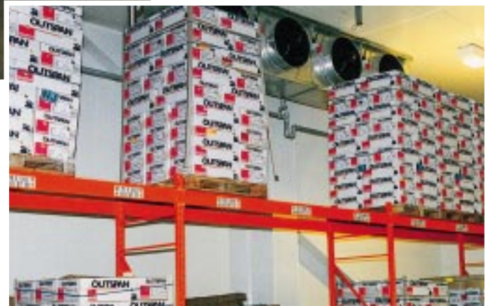
Bananenreiferaum 15 °C. 4 Küba Ventilatorluftkühler Typ SGA 113 in Sonderausführung für Luftführung über Zwischendecke. Luftaustritt über Gitter an den Stirnwänden. Automatische Entlüftung nach Ansprechen des Ethylenkontrollsystems
