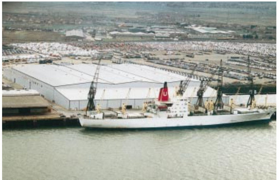
29 000 m 2 Kühlterminal für Kap-Früchte aus Südafrika. Größtes Kühlhaus in Großbritannien. Anlandung von 2000 Tonnen Weintrauben und Rosinen durch die „Snow Land“ im Tiefwasserhafen von Sheerness
