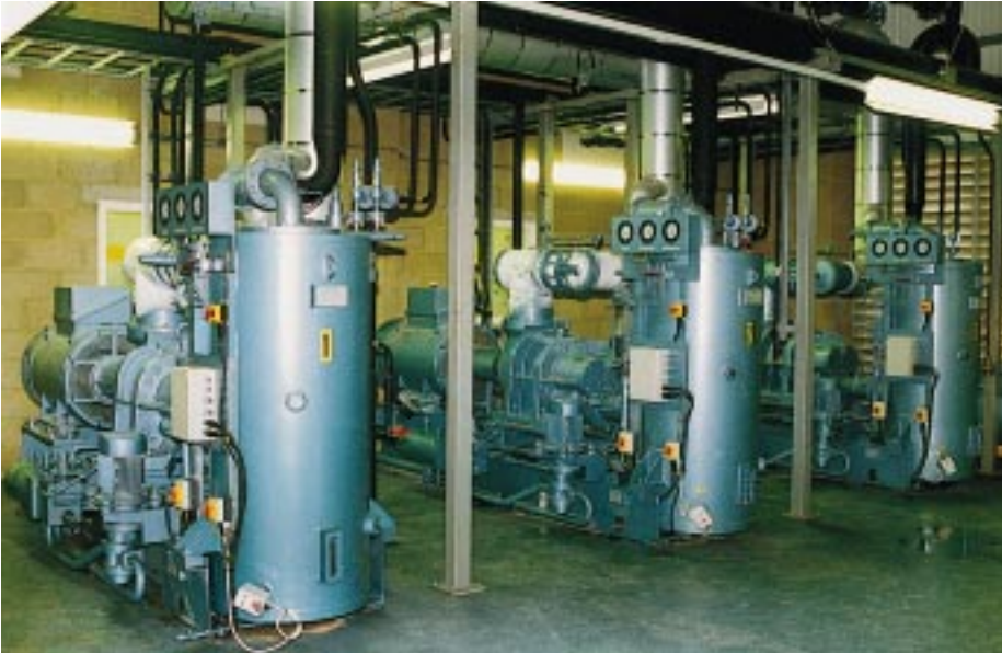
Drei Schraubenverdichter-Aggregate von Grasso GmbH Refrigeration Technology mit dem Kältemittel \text{NH}_3 (R 717) sorgen für die einwandfreie Kühlung des Fresh-Fruit-Terminals im Hafen von Sheerness. Gesamtkälteleistung 3665 kW
