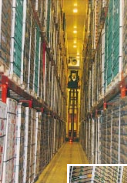
Größenverhältnisse; Obst braucht Raum. Jeder der 6 Obstlagerräume (RT = 7/9°C) mit 2267 m 2 ist 13,5 m hoch und wird durch 6 Ventilatorluftkühler Typ SGA 154 (an jeder Stirnwand 3) gekühlt
