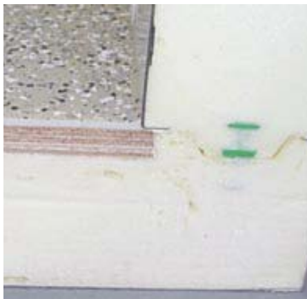
Übergang Boden/Wand mit Hohlkehle des neuen Kühl-/Tiefkühlzellenbodens von CELLTHERM
