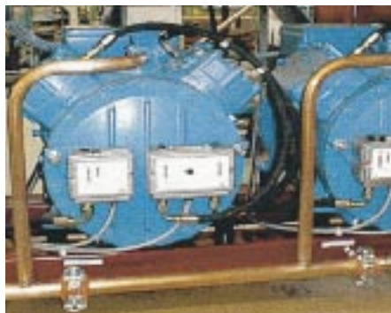
Bild 5 Verwendeter Verdichter – Frascold 4-Zylinder/Bauserie S
