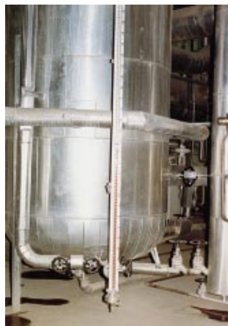
Bild 11 Anwendungsbeispiel einer Füllstandmessung
