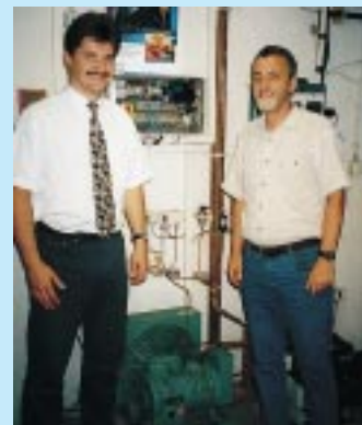
Die Herren Dahms (links), Danfoss und Naumann, Sächsische Kältefachschule, nach der Inbetriebnahme der neuen Anlage
