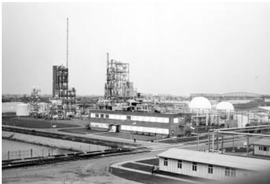
In Dordrecht (Niederlande) wurde von Du Pont das erste Fluorkohlenwasserstoffwerk in Europa erstellt, die Produktion wurde 1963 aufgenommen
