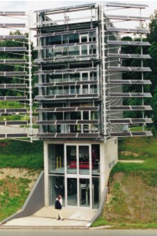
Reiner Bertuleit mit einem Mitarbeiter vor dem Technikurm, in dessen Erdgeschoß sich der Berieselungsverdampfer bzw. erstem Stock sich die Primärwärmepumpen befinden
