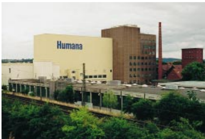
Die Abwärme der Humana Milchwerke dient als Wärme- quelle ...
