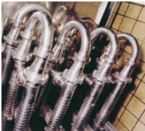
Die Bucospirex-Spiralrohr-Wärmeaustauscher zur Kühlung der Schmieremulsionen
