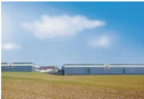
Mit dem Neubau hat REMKO sein bestehendes Lager- und Versandzentrum um weitere 2300 m 2 erweitert
