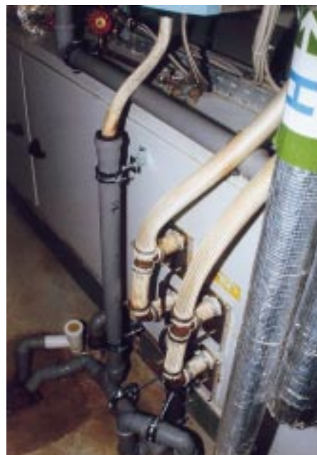
Teilansicht über die Anordnung der Dampfver- teilerrohre. Links daneben der großdimensi- onierte Wasserablauf für das in der Serie AT 3000 eingebaute Wasser-Selbstreinigungssy- stem
