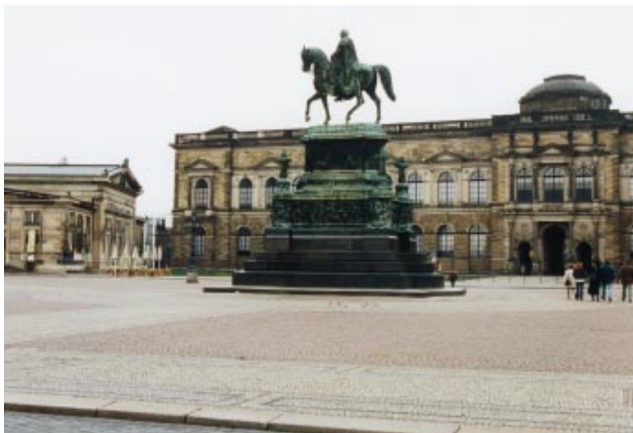
Teilansicht des Semperbaus am Zwinger in Dresden. Hierin untergebracht die Gemäldegalerie Alte Meister
