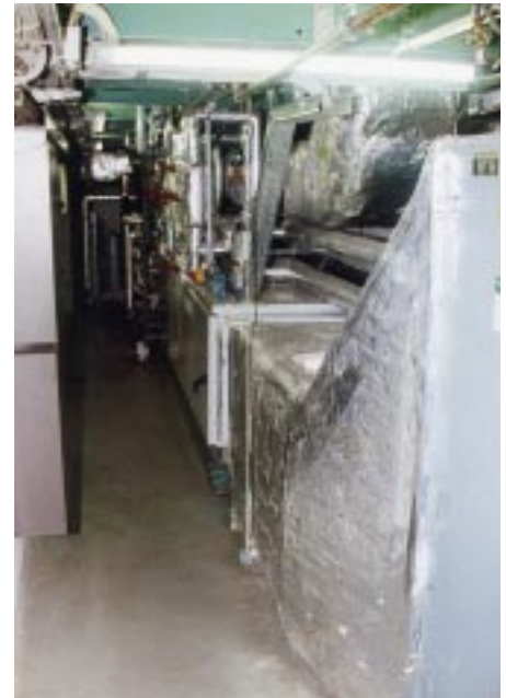
Bei teilweise abenteuerlich engen Platzverhältnissen mußten bei der Nachrüstung des Semperbaus 18 Zentralklimageräte mit jeweils bis zu 10 000 m 3 /h Luftleistung installiert werden
