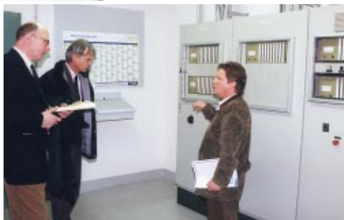
Alle Klimasysteme für Sempgalerie und Albertinum werden von einem Gebäudeleitsystem gesteuert und überwacht. Am PC ist jede einzelne Anlagenkonfiguration mit Mausclick zu visualisieren
