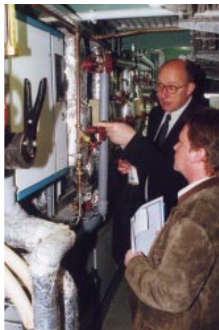
Insgesamt 12 Elektroden-Dampfluftbefeuchter des Fabrikates Nordmann sind in den Klimazentralen integriert. Konstrukteur Jacques Nordmann bei einem Erfahrungsaustausch über die ältere Gerätegeneration mit Eberhard Seack von der Sempgalerie (linkes Bild), auf dem rechten Bild wird das sich selbstreinigende Gerät AT 3000 auch mit Dr. Arndt von der Firma Kaut diskutiert
