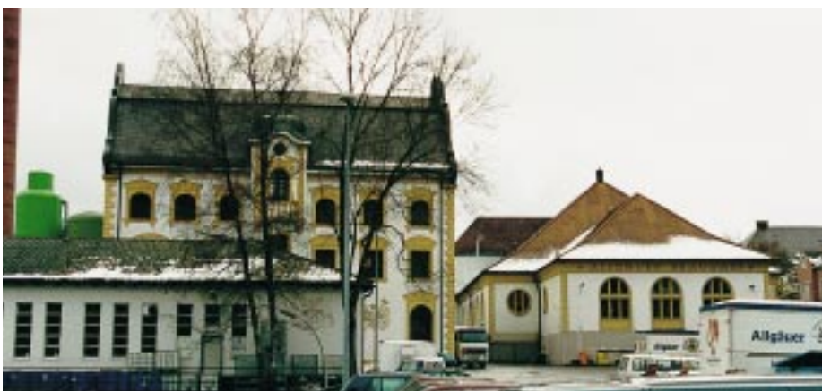
Das Allgäuer Brauhaus verfügt mit seinem über 600jährigen Bestehen über eine lange Tradition und mit seiner neuen Binäreisanlage jetzt über modernste Kältetechnik
