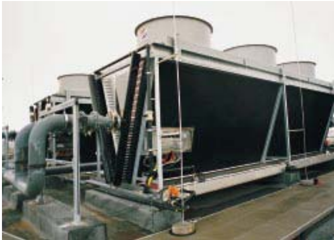
Bild 11 Ausführungsbeispiel hybride Trockenrückkühlanlage
