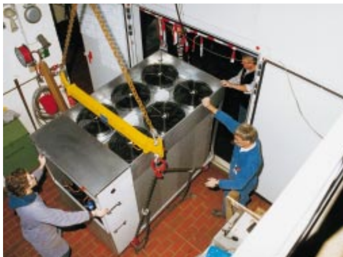
Die fachkundige Prüfung kälte-/klimatechnischer Komponenten und Anlagen
