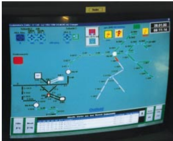
Diese visuelle Darstellung des Westfeldes am PC vermittelt einen Eindruck über das ca. 50 Kilometer umfassende Transportbandnetz, das das gewonnene Salz vorerst in unterirdischen Bunkeranlagen befördert
