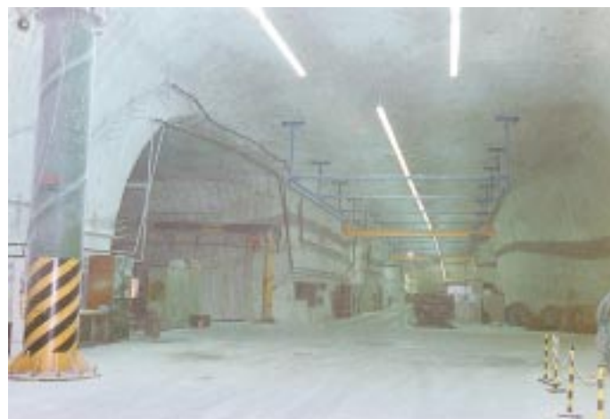
Wie hier auf den Bildern zu erkennen ist, reicht die Streckenhöhe von ca. 3,50 m bis zur Gewölbehöhe von 7,00 m im Werkstattbereich
