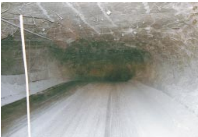
Wie hier auf den Bildern zu erkennen ist, reicht die Streckenhöhe von ca. 3,50 m bis zur Gewölbehöhe von 7,00 m im Werkstattbereich
