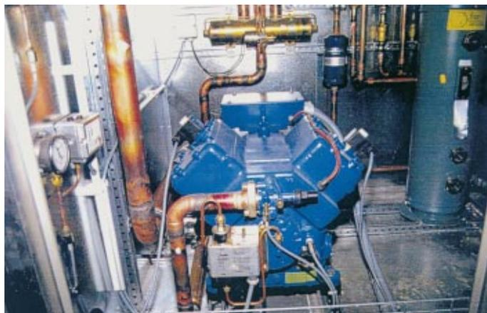
Bock-Kältesatz Typ HGX6/1410. Mit dem Kältemittel R 407C für eine Wärmepumpenschaltung geeignet
