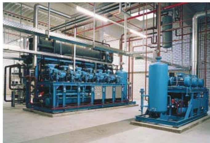
Bild 12 Verbundkältesätze der Kälteanlage in Brandenburg
