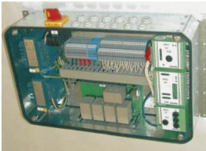
Bild 4 Regel- elektronik für Luft- erhitzer, bestehend aus Stahlblechanbau- gehäuse, Busregel- modulen, Leistungs- teil (Trafosteuerung) und Hauptschalter
