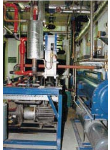
Umweltfreundliche und energiesparende Binäreistechnologie. Der Binäreisenerzeuger (Fabrikat Integral) ist außen mit Dämmplatten fugendicht isoliert, drei offene Hubkolbenverdichter (Fabrikat HKT Huber, System Goeldner) erreichen im Verbund eine Kälteleistung von 150 kW/h
