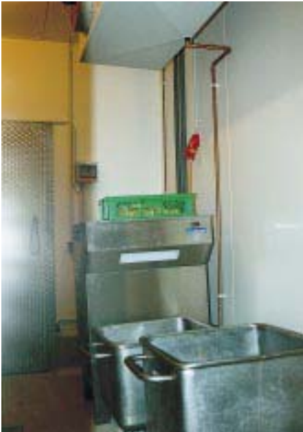
Selbst der Scherbeneisbereiter wird mit Binäreis betrieben, die Ventilatorluftkühler benötigen bis zu 0°C keinerlei elektrische Abtauung. Die eine Nahaufnahme zeigt die Strangabsperrventile am Kühlstellenaustauscher (Fabrikat Küba), die andere Nahaufnahme Kugelabsperr- und Magnetventil. Die Kühlstellenpumpe ist auf dieser Aufnahme nicht zu sehen. Gegen eine mögliche Tropfwasserbildung dient die in Richtung Luftansaugung verlängerte Tauwasserfangschale
