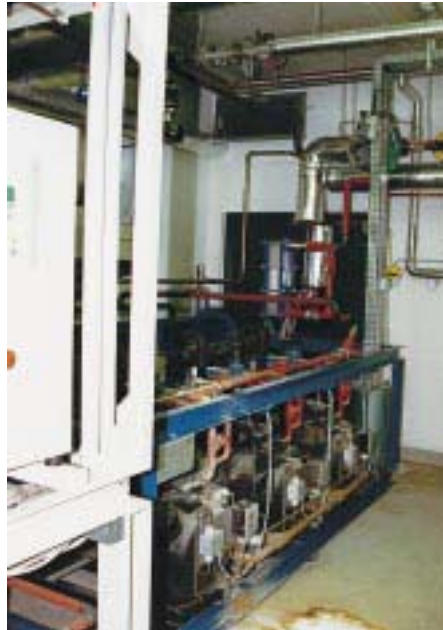
Umweltfreundliche und energiesparende Binäreistechnologie. Der Binäreisenerzeuger (Fabrikat Integral) ist außen mit Dämmplatten fugendicht isoliert, drei offene Hubkolbenverdichter (Fabrikat HKT Huber, System Goeldner) erreichen im Verbund eine Kälteleistung von 150 kW/h
