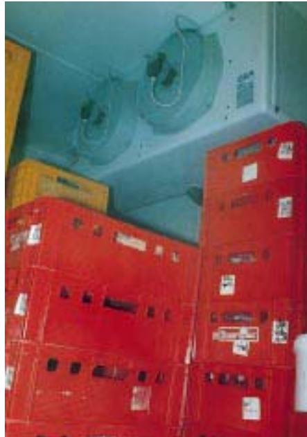
Selbst der Scherbeneisbereiter wird mit Binäreis betrieben, die Ventilatorluftkühler benötigen bis zu 0°C keinerlei elektrische Abtauung. Die eine Nahaufnahme zeigt die Strangabsperrventile am Kühlstellenaustauscher (Fabrikat Küba), die andere Nahaufnahme Kugelabsperr- und Magnetventil. Die Kühlstellenpumpe ist auf dieser Aufnahme nicht zu sehen. Gegen eine mögliche Tropfwasserbildung dient die in Richtung Luftansaugung verlängerte Tauwasserfangschale
