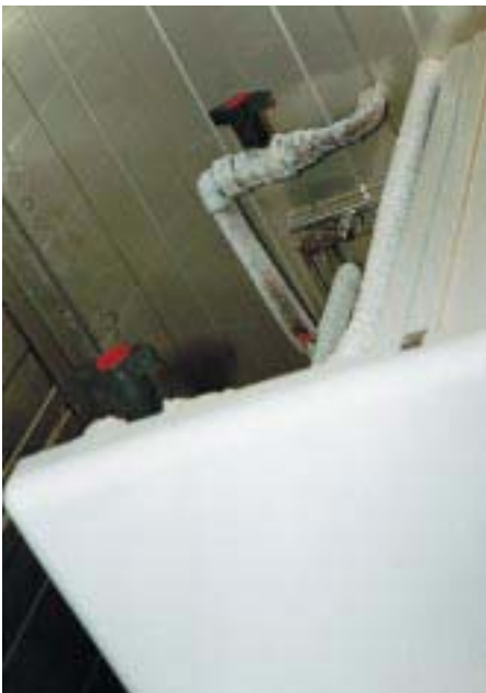
Selbst der Scherbeneisbereiter wird mit Binäreis betrieben, die Ventilatorluftkühler benötigen bis zu 0°C keinerlei elektrische Abtauung. Die eine Nahaufnahme zeigt die Strangabsperrventile am Kühlstellenaustauscher (Fabrikat Küba), die andere Nahaufnahme Kugelabsperr- und Magnetventil. Die Kühlstellenpumpe ist auf dieser Aufnahme nicht zu sehen. Gegen eine mögliche Tropfwasserbildung dient die in Richtung Luftansaugung verlängerte Tauwasserfangschale
