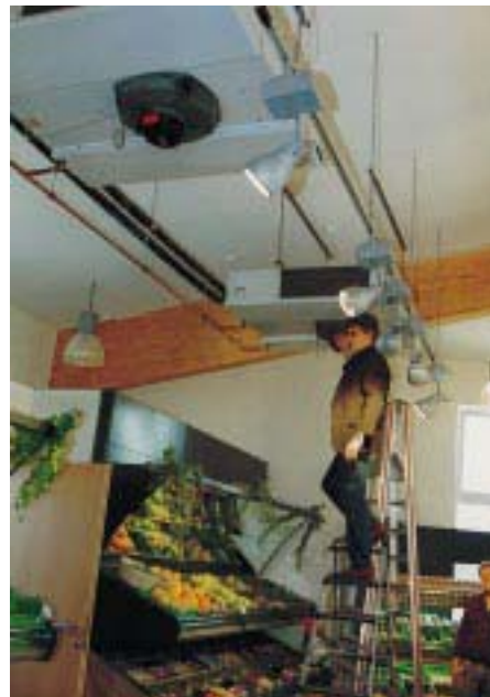
Lichtdurchflutet der Eingangs- und Kassenzonenbereich, hier begleitet den Einkauf ein angenehmes Verweilgefühl. Binäreisklimatisiert die Obst- und Gemüsezone, die Kühlstellenwärmeaustauscher arbeiten als Deckenluftkühler weitgehendst zugfrei
