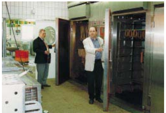
Auch für die Räuchereinrichtungen erfolgt die Kälteversorgung mittels Binäreis
