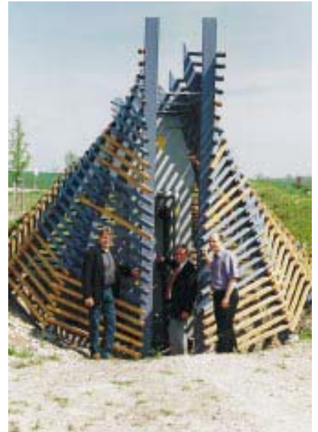
Nicht nur ökologische Kunst am Bau, sondern hinter der offenen Holzverkleidung des „Vulkans“ (wegen der temperaturabhängig sichtbaren Verdunstungswolke) verbirgt sich der Verdunstungskühler als Wärmerückgewinnungskomponente
