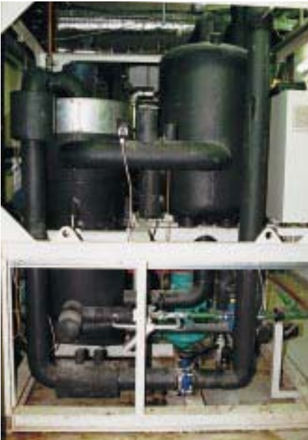
Umweltfreundliche und energiesparende Binäreistechnologie. Der Binäreisenerzeuger (Fabrikat Integral) ist außen mit Dämmplatten fugendicht isoliert, drei offene Hubkolbenverdichter (Fabrikat HKT Huber, System Goeldner) erreichen im Verbund eine Kälteleistung von 150 kW/h
