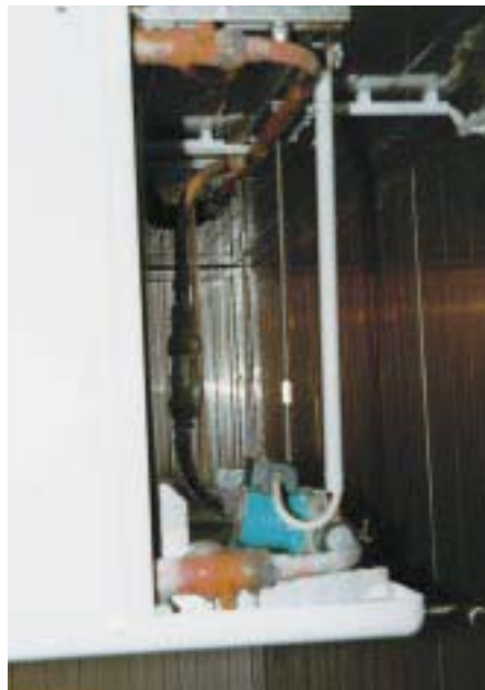
Selbst der Scherbeneisbereiter wird mit Binäreis betrieben, die Ventilatorluftkühler benötigen bis zu 0°C keinerlei elektrische Abtauung. Die eine Nahaufnahme zeigt die Strangabsperrventile am Kühlstellenaustauscher (Fabrikat Küba), die andere Nahaufnahme Kugelabsperr- und Magnetventil. Die Kühlstellenpumpe ist auf dieser Aufnahme nicht zu sehen. Gegen eine mögliche Tropfwasserbildung dient die in Richtung Luftansaugung verlängerte Tauwasserfangschale
