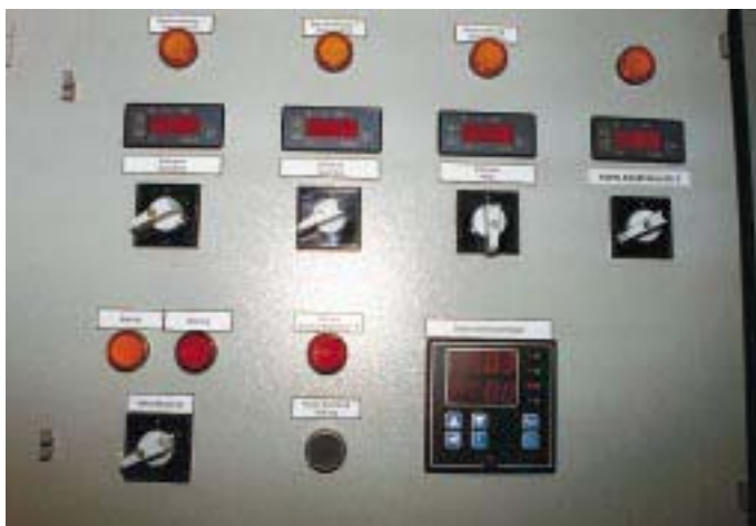
Kälteanlagenbauermeister Peter Klausner (HEIFO Hannover) erläutert KK die gesonderte Binäreis-Vor- und Rücklauftechnik für den Bierherstellungsprozeß. Die Haupttemperaturanzeige am gesonderten Schaltschrank zeigt es, die Binäreisvorlauftemperatur beträgt 0,3 °C, 0 °C wäre die maximal zulässige untere Grenze
