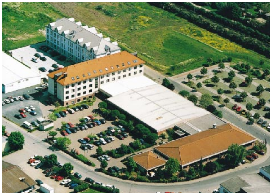
Die Bundesfachschule Kälte-Klima-Technik mit dem angebauten Internat (mehrstöckiges Gebäude) sowie dem Europäischen Haus der Kälte (links oben)
