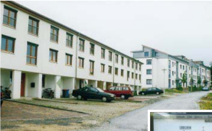
16 dezentrale Wärmepumpen nutzen die Abwärme der Humana Milchwerke zur Beheizung von 240 Wohneinheiten im Wohnpark Sattlerweg in Herford
