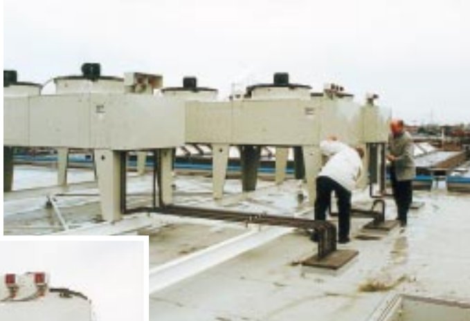
Dachaufstellung der luftgekühlten Axialverflüssiger, Baureihe CAV S09 von Küba, mit korrosionshemmenden Goldlack-Lamellen, auf dem Dach des Großverbrauchermarktes. In das Wärmetauscherpaket ist jeweils ein gesonderter Unterkühlkreislauf integriert
