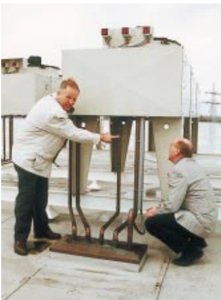
Dachaufstellung der luftgekühlten Axialverflüssiger, Baureihe CAV S09 von Küba, mit korrosionshemmenden Goldlack-Lamellen, auf dem Dach des Großverbrauchermarktes. In das Wärmetauscherpaket ist jeweils ein gesonderter Unterkühlkreislauf integriert
