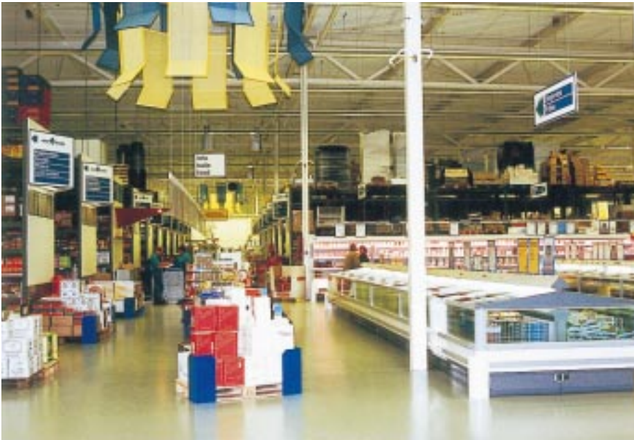
Eindrücke aus dem Lukas Klamer Großverbrauchermarkt in Nijmegen. Alle offenen Tiefkühlinseln sind ganztägig mit Glasschiebedeckeln von Remis abgedeckt. Das ergibt eine Energieersparnis von ca. 50 % und die Zurverfügungstellung von „Kälte“ konnte bei der Verdichterauswahl in der Leistung von vornherein um 34 % reduziert werden
