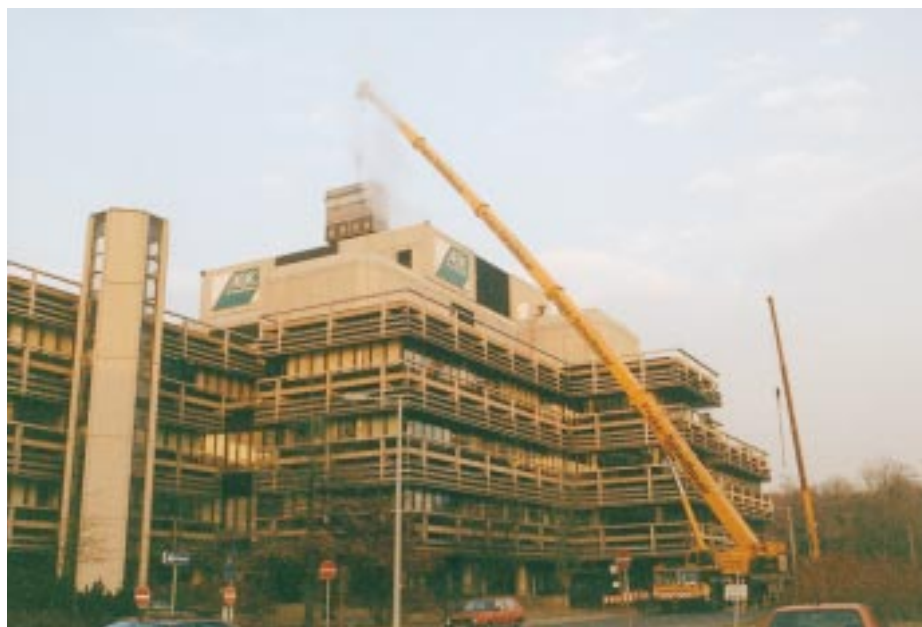
Einbringung einer Kältemaschine in die Regionaldirektion der AOK in Hannover
