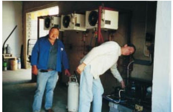
Praktischer Prüfungsteil: Inbetriebnahme und Füllen eines Kaltwassersatzes (linkes Bild), umweltgerechte Entleerung und anschließende Neubefüllung einer Kälteanlage für die Kühlzelle (rechtes Bild)
