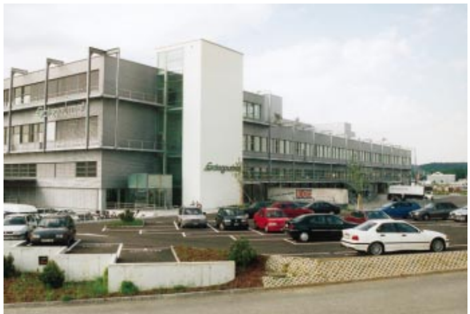
Das neue Betriebsgebäude der Swissair-Tochter Gategourmet auf dem Flughafen Zürich Kloten
