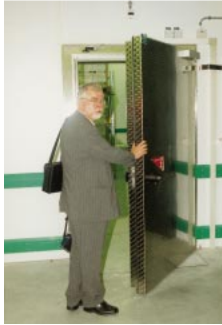
In bestimmten Gebäudeabschnitten mußten Kühl- und Tiefkühlräume in Brandschutzausführung erstellt werden. Hier die dazugehörigen Schiebe- und Drehtüren von Coolit
