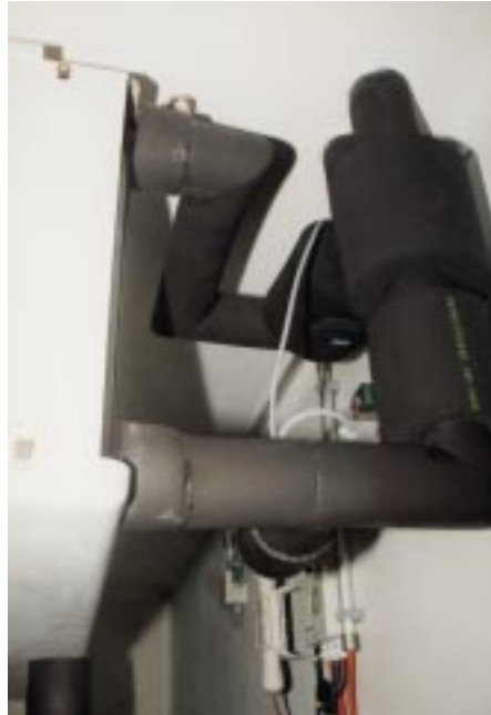
Die Ventilatorluftkühler sind an der Decke mit 10 cm Distanzschrauben zur besseren Hygienereinigung befestigt. Die Kältschleifungen sind mit Armaflex isoliert
