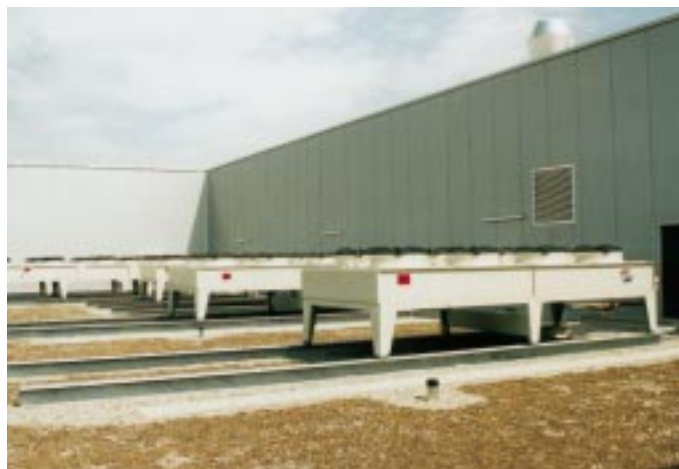
Rückkühler (Baureihe GFH) und Axialverflüs-siger (Baureihe GVH) von Güntner
