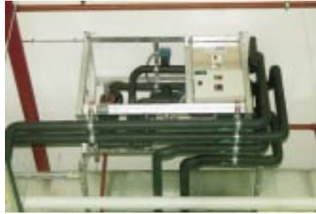
Auch die Umluftkühler (Fabrikat Lippuner, hier mit Torluftschleier) wurden von P & P über sogenannte Unterstationen mit Kaltwasser versorgt
