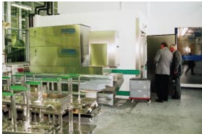
Auch die Umluftkühler (Fabrikat Lippuner, hier mit Torluftschleier) wurden von P & P über sogenannte Unterstationen mit Kaltwasser versorgt
