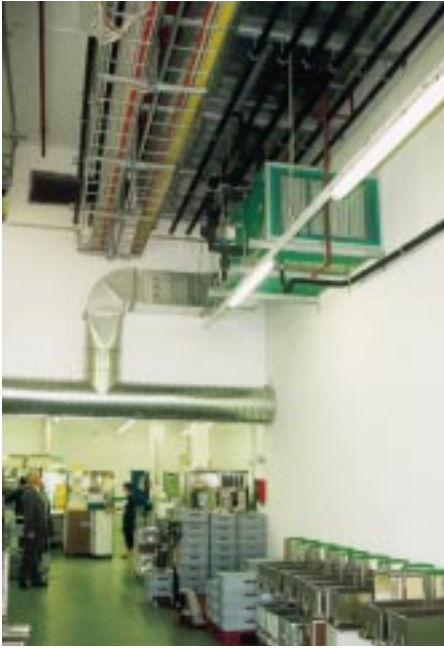
Auch die Umluftkühler (Fabrikat Lippuner, hier mit Torluftschleier) wurden von P & P über sogenannte Unterstationen mit Kaltwasser versorgt
