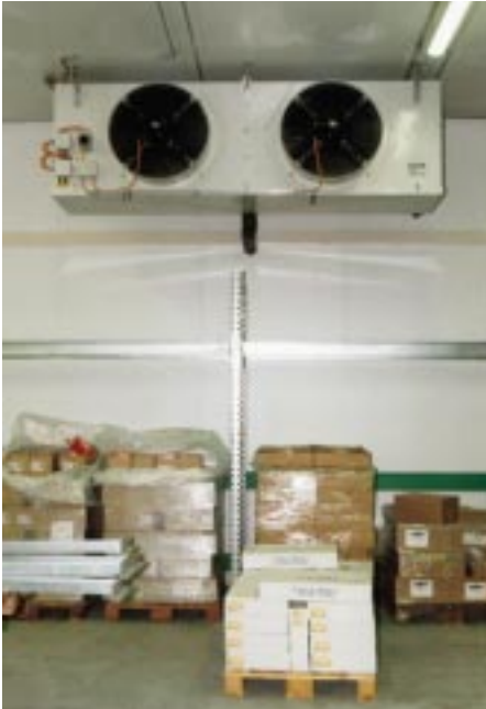
Die Ventilatorluftkühler sind an der Decke mit 10 cm Distanzschrauben zur besseren Hygienereinigung befestigt. Die Kältschleifungen sind mit Armaflex isoliert
