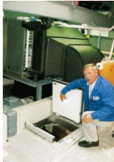
Ein Blick über die Inspektionsöffnung in den 20 m hohen/tiefen Shuttle in dem die Trolleys bis zur Weiterbehandlung bei +2 °C/+4 °C automatisch befördert und geparkt werden
