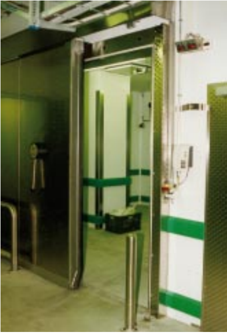
In bestimmten Gebäudeabschnitten mußten Kühl- und Tiefkühlräume in Brandschutzausführung erstellt werden. Hier die dazugehörigen Schiebe- und Drehtüren von Coolit
