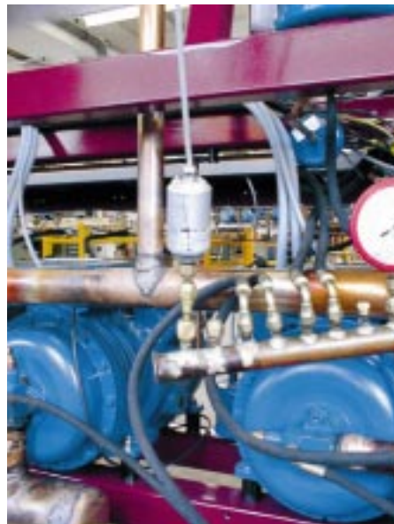
Überdruckprüfung mit getrocknetem Stickstoff bei ca. 20 bar
