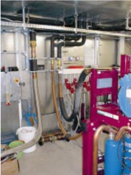
Vorbereitung des Verdichterlauftests mittels wiederverwendbaren Schnellverschlüssen
