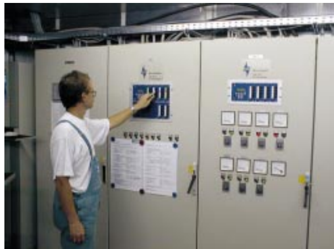
Der halbautomatische Testablauf wird mit einer komplexen Software auf der Basis des Wurm-Regelsystems FRIGOLINK® durchgeführt und ausgewertet
