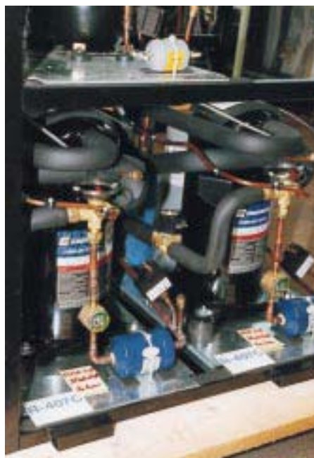
Kälteanlagenbauermeister Herbert Piergalski (Manching) erläutert hier die besondere Technologie der Direktexpansions/Direktkondensationswärmepumpe: 3 Verdichtermodule, 3 voneinander getrennte Verdampfungs- und Kondensationskreisläufe. Eingespritzt wird das Kältemittel R 407C mechanisch-thermisch
