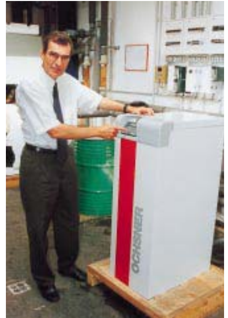
In jeder Wärmepumpe Golf Midi von Ochsner ist eine witterungsgeführte Regelung eingebaut
