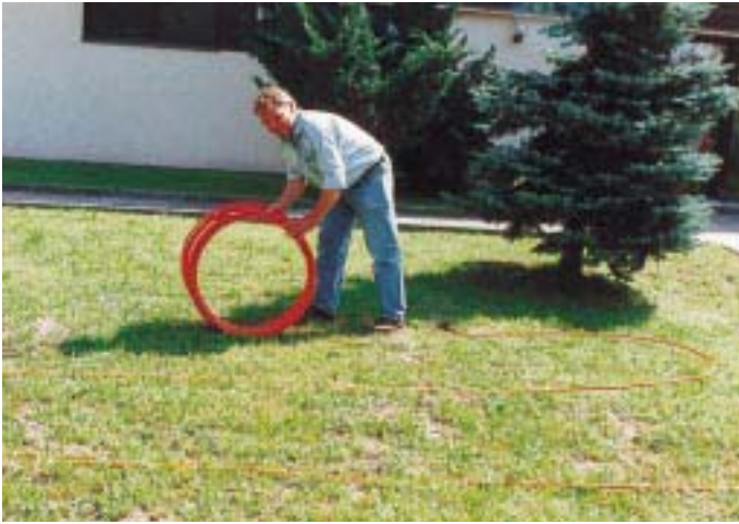
Kälteanlagenbauermeister Herbert Piergalski zeigt hier, in welcher Weise Erdreich-Flachkollektoren „abgerollt“ und mäanderförmig im Abstand von ca. 1,00 m verlegt werden müssen
