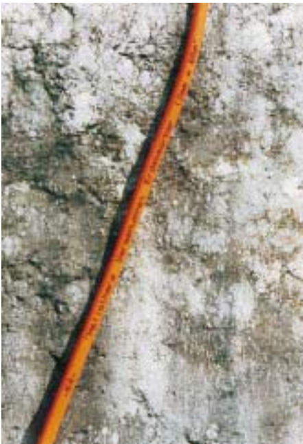
Flachkollektoren für direkt verdampfendes Kältemittel sind Erdabsorber aus PE-ummanteltem Kupferrohr gemäß DIN 59753 (Kühlschrankqualität), 12 mm im Durchmesser
