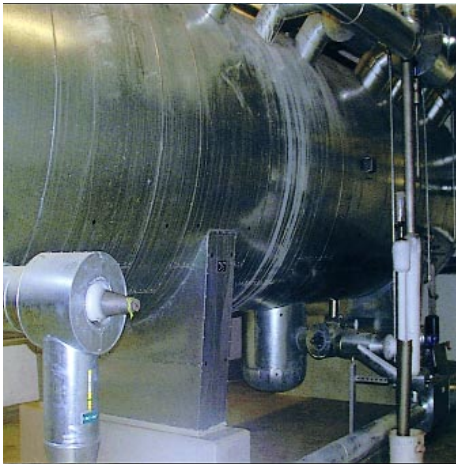
Störstrahlung durch die bereifte Füllstandsanzeigeeinrichtung am Abscheider
