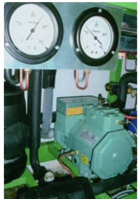
Der eingesetzte halbhermetische CO 2 -Verdichter von Bitzer
