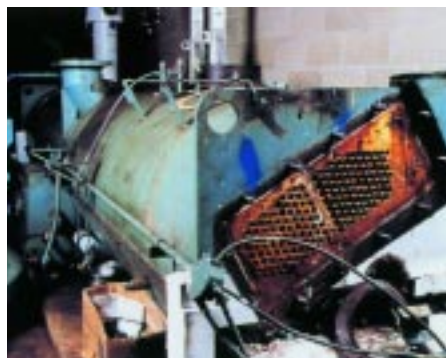
Überprüfung von Verdampfer und Verflüssiger
