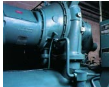
Die neue YORK Codekit Driveline nach erfolgter Umrüstung
