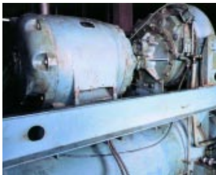
Die alte R 11-Driveline vor dem Austausch
