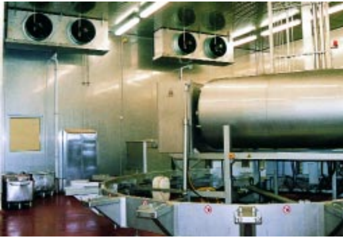
PEP-Verdampfer in einem Wurstbrät- und einem Tumbler-Nachkühlraum für die Herstellung von Schinken
