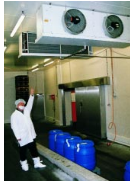
PEP-Verdampfer in einem Versandraum für Fleischprodukte in Heilsbronn mit einer Raumtemperatur von + 2 °C. Permanent-Hochleistungsluftkühler, hier in einer Rücken an Rückenordnung bleiben bei Raumtemperaturen von > 1 °C nahezu eisfrei. Hier auch an den Rohrbögen zu erkennen
