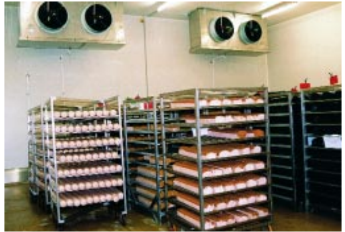
PEP-Verdampfer in einem Wurstbrät- und einem Tumbler-Nachkühlraum für die Herstellung von Schinken
