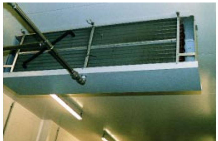
PEP-Verdampfer in einem Versandraum für Fleischprodukte in Heilsbronn mit einer Raumtemperatur von + 2 °C. Permanent-Hochleistungsluftkühler, hier in einer Rücken an Rückenordnung bleiben bei Raumtemperaturen von > 1 °C nahezu eisfrei. Hier auch an den Rohrbögen zu erkennen
