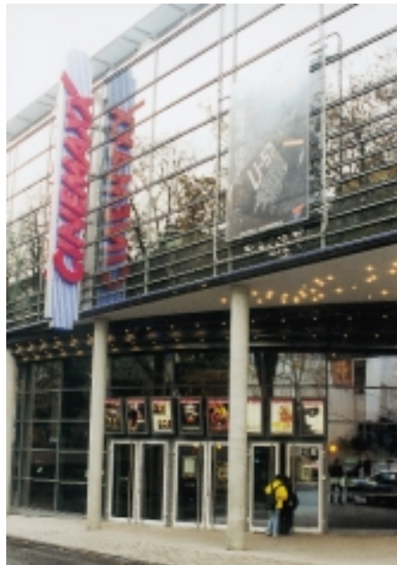
Hinter dieser gläsernen Fassade verbirgt sich außer den 7 Kinosälen auch eine solide Klimaanlage
