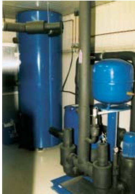
Teilansicht Maschinenraum mit Maschinengestell, Pumpenstation und Pufferspeicher
