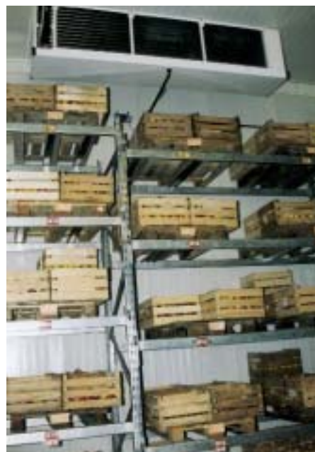
Die Stapelhöhe des Obstlagergutes darf keinesfalls höher als bis Unterkante Ventilatorluftkühler sein. Auch ein ausreichender Wandabstand trägt zu einer guten Luftwalzenbildung bei
