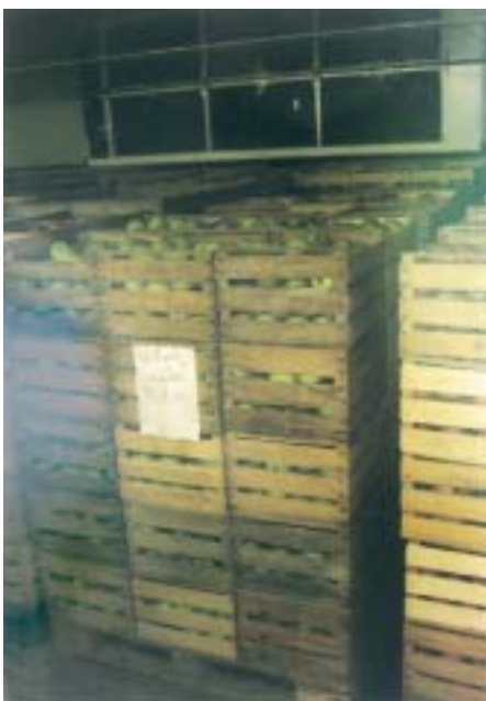
Die Stapelhöhe des Obstlagergutes darf keinesfalls höher als bis Unterkante Ventilatorluftkühler sein. Auch ein ausreichender Wandabstand trägt zu einer guten Luftwalzenbildung bei
