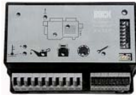
Neu: Das Bock-Compressor-Management-System BCM ist mit vielen neuartigen Überwachungsfunktionen ausgestattet
