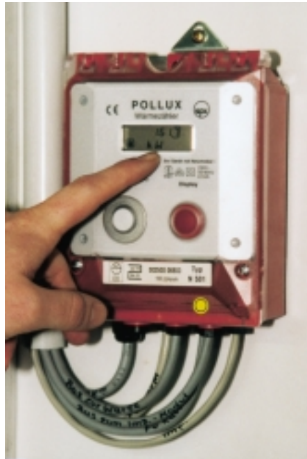
Als Contractor verkauft die EnBW an Gambro ausschließlich Kälteenergie und gewährt die Versorgungssicherheit – eine klare, eindeutige Schnittstelle also
