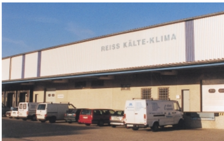
Die Niederlassung der Firma Reiss in Gerichshain bei Leipzig bietet hinter der modernen Fassade ein umfangreiches Sortiment von Kältekomponenten
