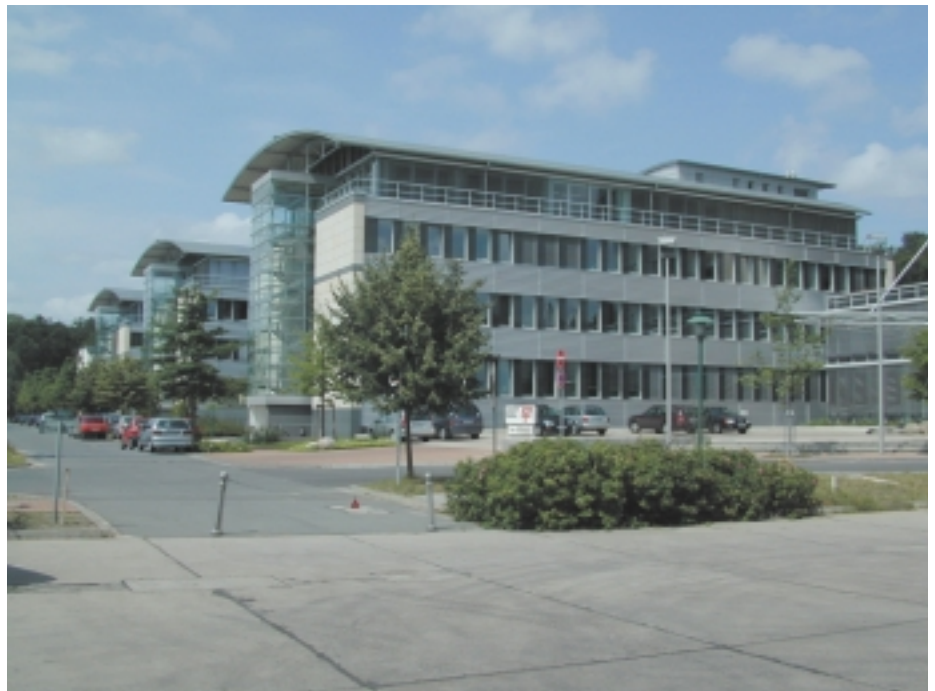
Beispiel für die Zusammenführung unterschiedlicher Gebäudeautomationssysteme auf eine gemeinsame Bedienebene: Das Verwaltungsgebäude der Investitionsbank des Landes Brandenburg in Potsdam
