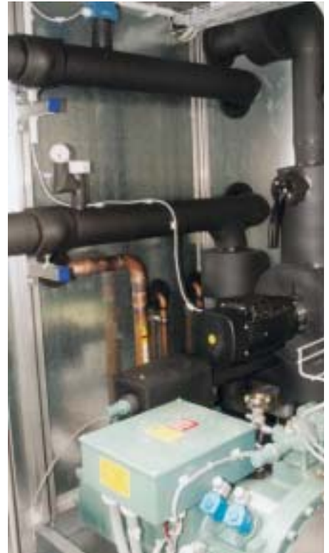
Sobald die Außentemperaturen es zulassen, schaltet die Anlage auf freie Kühlung um, und die eingebaute Pumpe sorgt für die Umgehung der Kälteanlage
