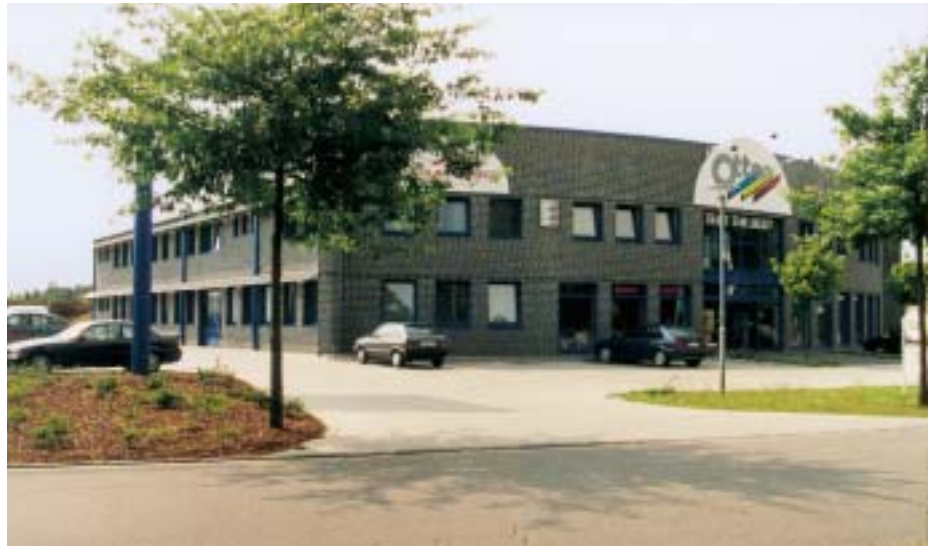
Der 1999 bezogene neue Firmensitz wurde als Passivhaus gebaut und ist mit interessanten haustechnischen Lösungen ausgestattet
