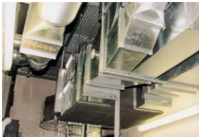
Die über zwei Zulufttürme angesaugte Außenluft durchströmt zuerst zwei Erdrohr-Wärmetauscher, ...
