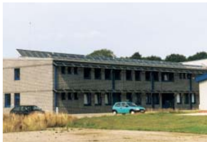
Die Südansicht des Gebäudes: Deutlich zu erkennen sind die Solarzellen, die über den Fenstern angeordnet gleichzeitig auch der Beschattung dienen, sowie auf dem Dach die Kollektoren für die Erwärmung des Brauch- bzw. Heizwassers
