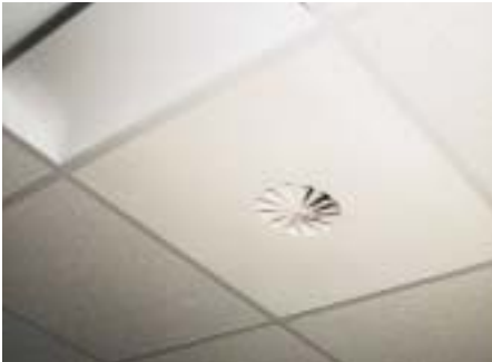
... ehe sie schließlich über Luftauslässe jedem Raum einzeln zugeführt wird
