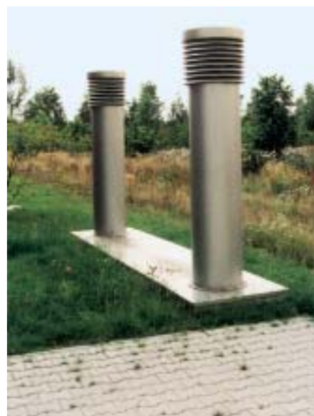
Die über zwei Zulufttürme angesaugte Außenluft durchströmt zuerst zwei Erdrohr-Wärmetauscher, ...
