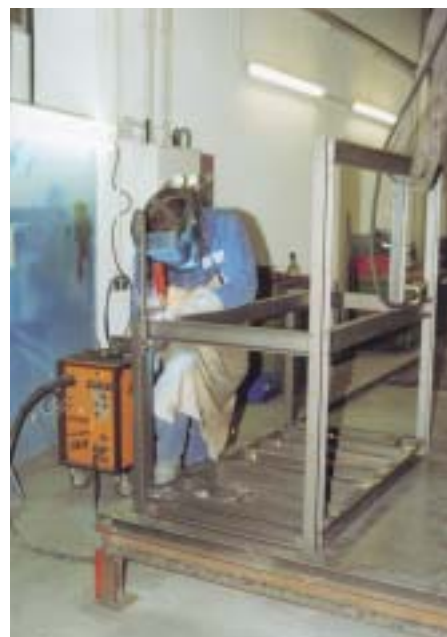
Die Stahlbauhalle bietet genügend Platz auch für die Fertigung großer Maschinengestelle. Durch die Verwendung von sandgestrahltem Stahl wird eine gute Qualität der Farbbeschichtung erreicht
