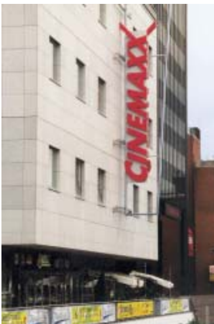
Zu den Abnehmern der Kälteenergie zählen ein CinemaxX-Kino ...
