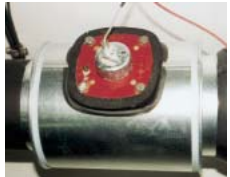
. . . und für erzeugte Kälteenergie. Der Vergleich dieser Werte ermöglicht die Kontrolle des Anlagenwirkungsgrades
