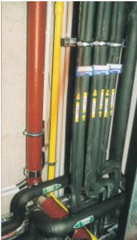
Über 900 m Kupferrohr wurden unter teilweise beengten Verhältnissen für die Kältemittelführung fachmännisch verlegt
