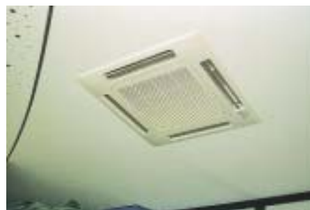
Innen wurden, wo möglich, Kassetten mit „unsichtbaren“ Leitungen installiert
