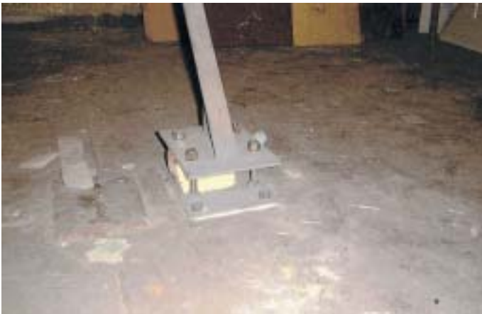
Nach der Demontage der Einbauten im Eisspeicher wurde der künftige Binäreisspeicher mit Sand gestrahlt und mit einem Haftgrund versiegelt. Danach wurden die Unterkonstruktionen der Aussteifungen und Stützstreben eingebaut
