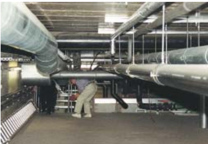
Zugang zum Aufstellungsort der neuen Verdunstungskühler. Lichte Durchgangshöhe zwischen 1,25 und 2,0 m
