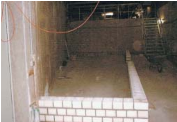
Erstellen der Abmauerung des neuen Maschinenraums im K 12 und Einbringen des ammoniakbeständigen Schutzanstrichs
