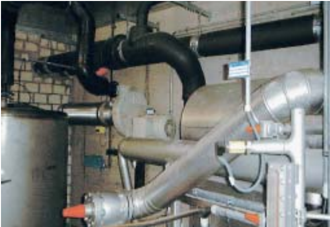
Sicherheitsventilator zum Reinigen der evtl. verseuchten Maschinenraum-atmosphäre mit dem Kältemittel Ammoniak
