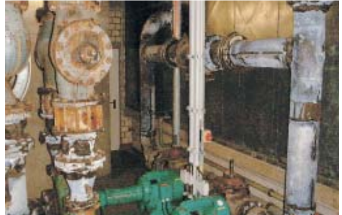
Demontage des Kältemittelabscheiders und der Anlagenteile aus dem Maschinenraum K 1. Unter der Isolierung des Abscheiders sowie an den Rohrbündeln wurden starke Verrostungen festgestellt
