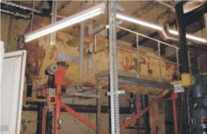
Demontage des Kältemittelabscheiders und der Anlagenteile aus dem Maschinenraum K 1. Unter der Isolierung des Abscheiders sowie an den Rohrbündeln wurden starke Verrostungen festgestellt
