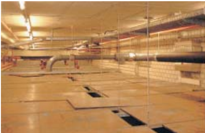
Einbau der Rührwerke, die immer für die notwendigen Eisanteile im Vorlauf sorgen. Die Abdeckung des Binäreispeichers erfolgte mit alten Abdeckplatten
