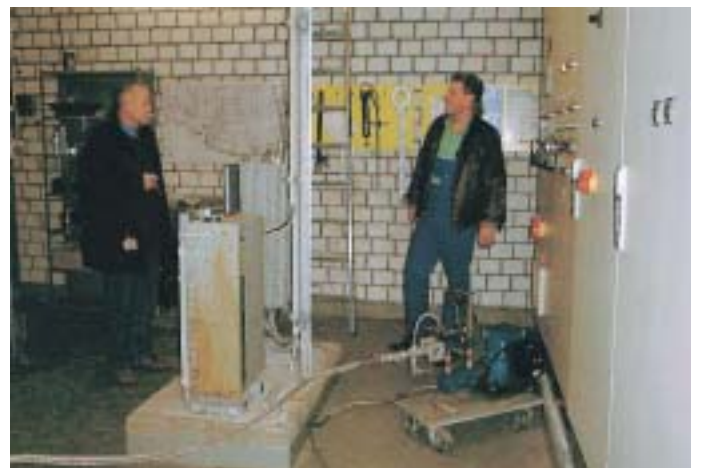
Vorbereitung zur Entleerung der Kältemittelfüllmenge R 22 mit einer zusätzlichen Kältemittelpumpe
