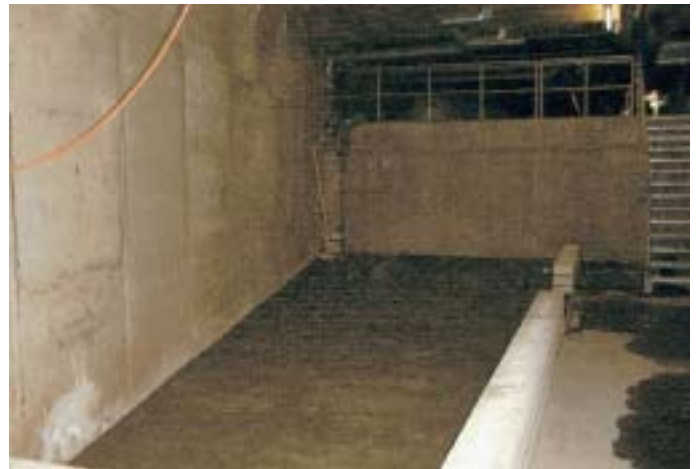
Erstellen der Abmauerung des neuen Maschinenraums im K 12 und Einbringen des ammoniakbeständigen Schutzanstrichs
