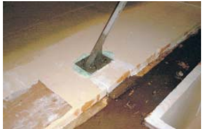
Nach der Demontage der Einbauten im Eisspeicher wurde der künftige Binäreisspeicher mit Sand gestrahlt und mit einem Haftgrund versiegelt. Danach wurden die Unterkonstruktionen der Aussteifungen und Stützstreben eingebaut
