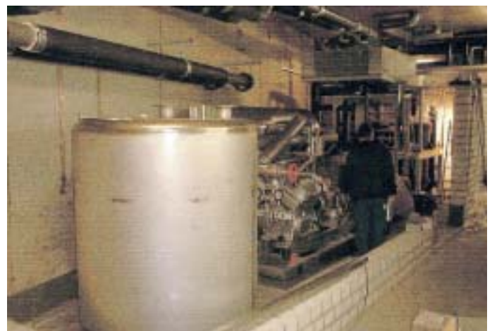
Einbau des Grundlastkühlers und des Ammoniak-Wasser-Sicherheitsvorlage-Behälters
