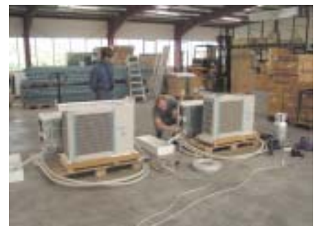
Umrüstung eines Klimagerätes auf das Kältemittel R 417A
