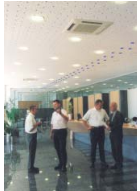
Innenarchitektonisch gelungene Einbindung der DAIKIN-Deckenkassetten FXYCP mit 4seitigem Ausblas in die abgehängte Decke im Bereich der Schalterhalle...
