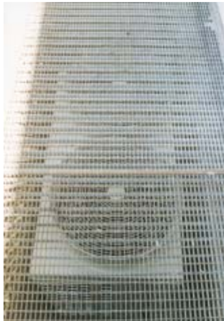
Für die Außeneinheit RSXYP10K mit zwei Axiallüftern wurde an der Rückseite des Gebäudes in einem Lichtschacht mit Gitterroste ein platzsparender Aufstellungsplatz gefunden
