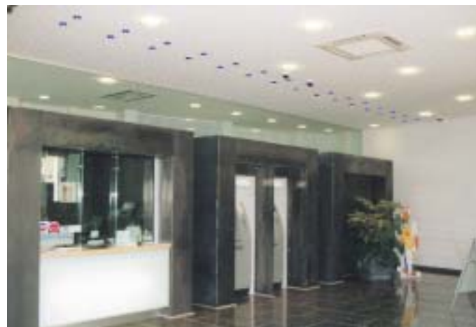
Innenarchitektonisch gelungene Einbindung der DAIKIN-Deckenkassetten FXYCP mit 4seitigem Ausblas in die abgehängte Decke im Bereich der Schalterhalle...
