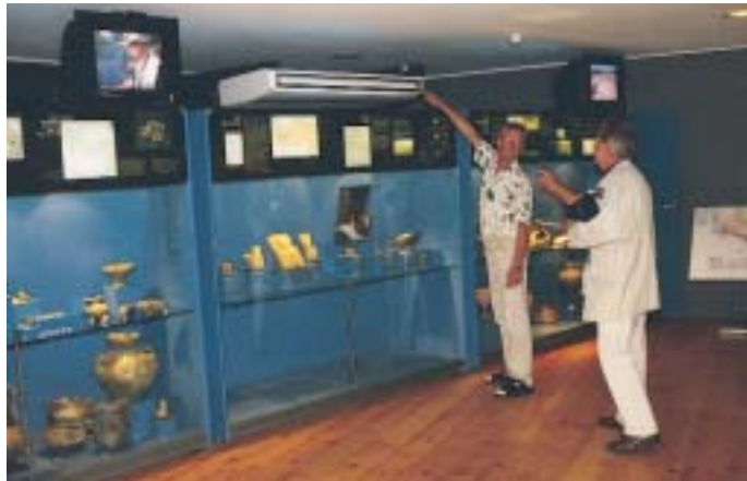
Die Vitrinen sind als Mauer von Troja VI gestaltet. Inbetriebnahme der Kaut/Sanyo-Splitklimaanlage. Bernd Bähre erläutert Museumsinspektor Hans-Jürgen Robl die Steuerung der Luftführungslamellen mittels Infrarotfernbedienung
