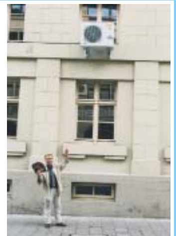
Ein Baukran war ein gutes Hilfsmittel, um über Nacht die beiden Sanyo-Klima-Außeneinheiten Typ SPW-TR253GH56 hoch zu hieven, um sie an der Außenwand des Landesmuseums vorübergehend zu befestigen. Trojas Raumtemperatur war danach gerettet
