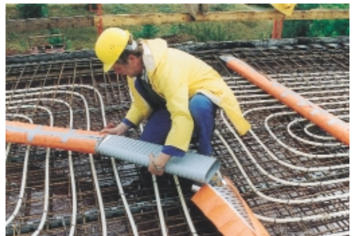
Montage der ovalen Lüftungskanäle Quadrox von Westaflex. Zum Schutz vor Korrosion werden die Rohre mit einer 4 mm starken PE-Folie ummantelt
