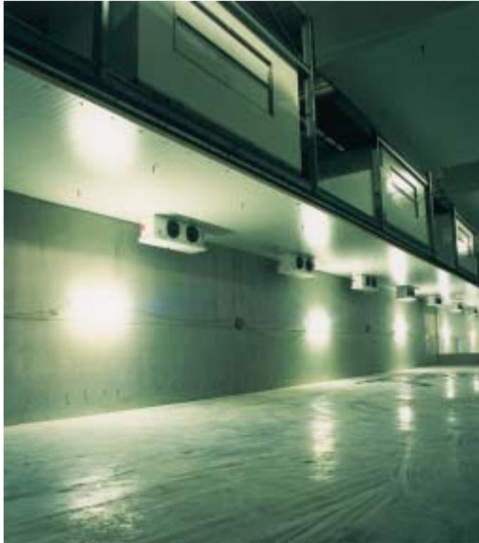
*Güntner präsentierte auf der IKK unter anderem Großprojekte mit Isolierkühler, Deckenluftkühler, Plattenwärmeübertrager und Rückkühler. Die Abbildung zeigt mehrere Isolierkühler, vorbereitet für den Kanalschluß zur Kühlung des Kommissionierbereichs, und Deckenluftkühler, vorbereitet zur Kühlung der darunter liegenden Obst- und Gemüse Kühlräume*
