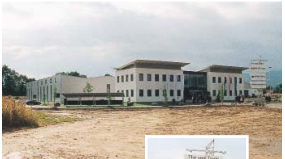
Auf einem Areal von 5700 m 2 wurden die neuen Produktions- und Verwaltungsgebäude in einer Rekordzeit von 24 Arbeitswochen aus dem Boden gestampft, . . .
