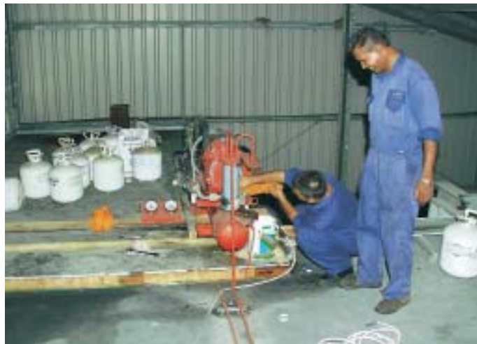
Das kann man sich hier gar nicht vorstellen: Auf Mauritius ist der Handel mit FCKW 12 unter Strafe gestellt. Wie kann man sich helfen? Zum Beispiel wie hier in einem Kartoffellager, wo unzählige Zylinder mit R 12 auf Vorrat gelagert werden. Auf dem danebenstehenden Foto wird auf einem demontierten Kühlzellendach die Möglichkeit eines Retrofits von R 12 auf R 134a geprüft
